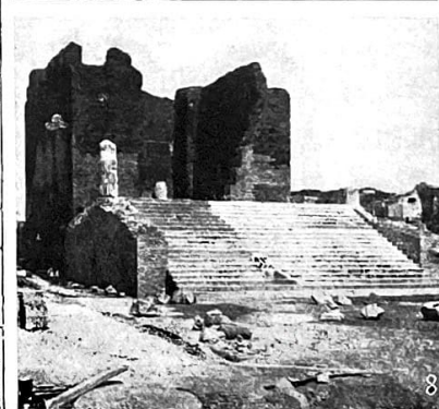
7. INGRESSO DELL'EDIFICIO DEI MISURATORI DEL GRANO. - 8. IL TEMPIO DI VULCANO.
